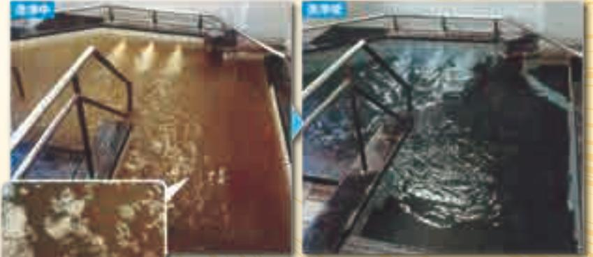
配管内の汚れが多い場合、汚れが浮き出てきます。
